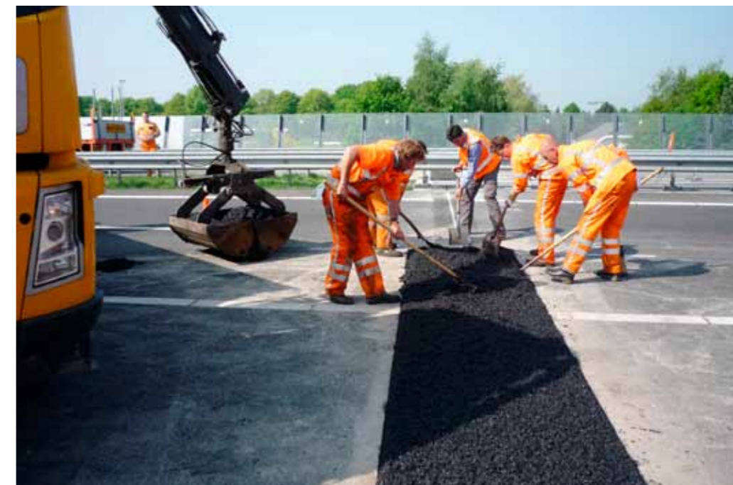
Afbeelding 51: Afwerking van de BrainJoint
