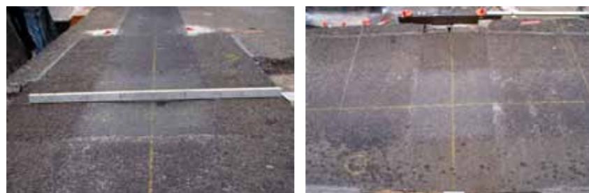
Afbeelding 32: De Prismo Joint na 98.000 lastherhalingen. Links: spoorvorming in de +13 mm voegovergang. Rechts: overzicht van de -13 mm voegovergang
