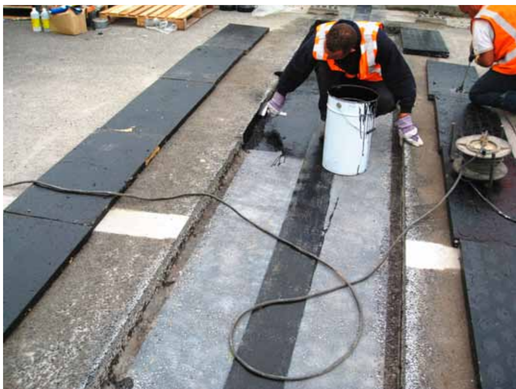
Afbeelding 59: Inbouw van de KLK Bituvoeg in de A50 bij Nistelrode
