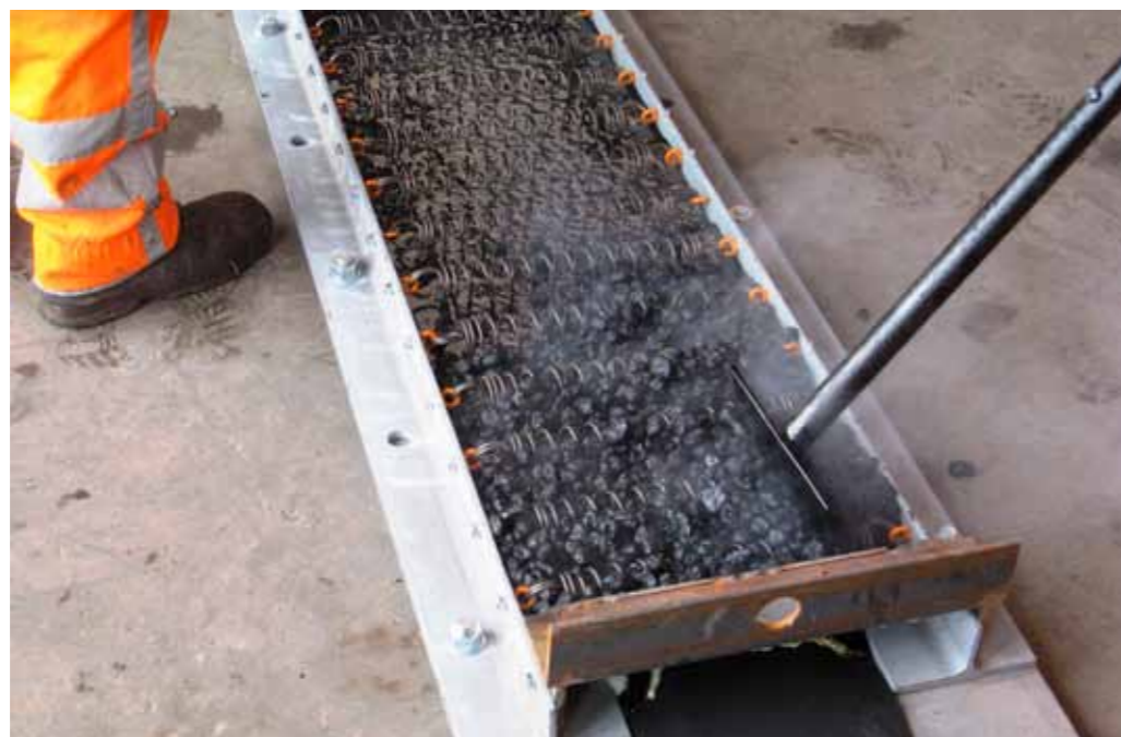
Afbeelding 50: Het prefab vervaardigen van de Silent Joint met verenpakket
