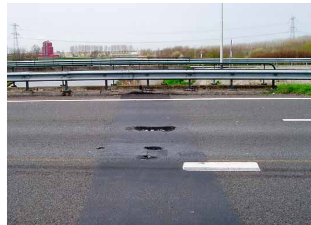
Afbeelding 8: Materiaalverlies in een bitumineuze voegovergang
