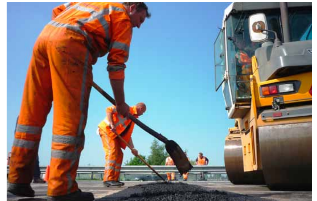
Afbeelding 3: Afwerking van de BrainJoint in de A50 bij Nistelrode
