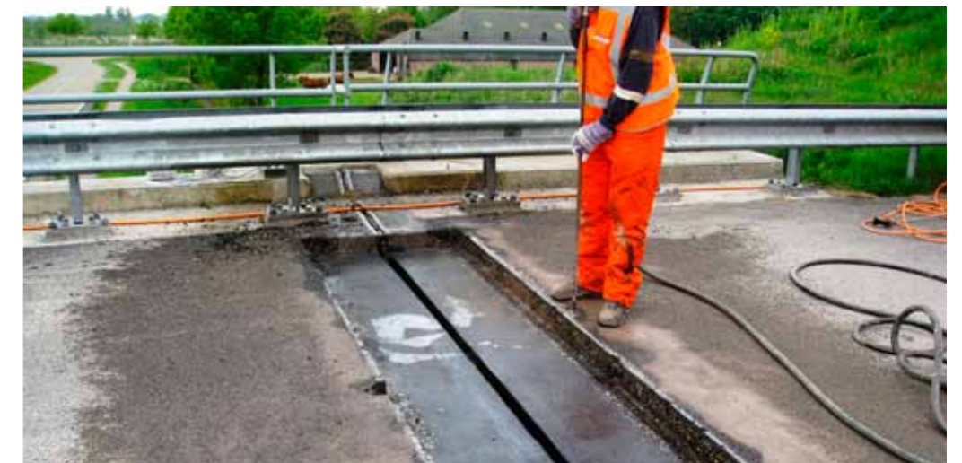
Afbeelding 1: Landhoofd en betonnen dek klaar voor inbouw nieuwe voegovergang
