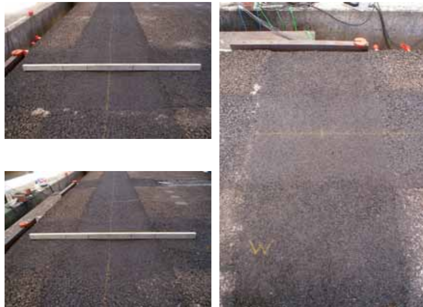
Afbeelding 29: Links: spoorvorming in de Prefab Silent Joint na 85.000 belastingsherhalingen. Rechts: overzicht van de +13 mm voegovergang
