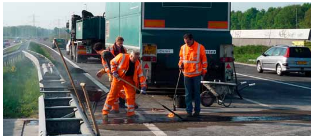
Afbeelding 2: Inbouw van de Prefab Silent Joint in de A50 bij Nistelrode
