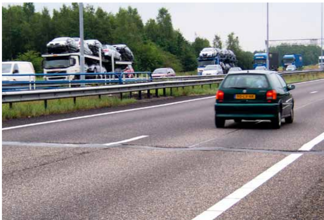
Afbeelding 6: Schade aan een bitumineuze voegovergang
