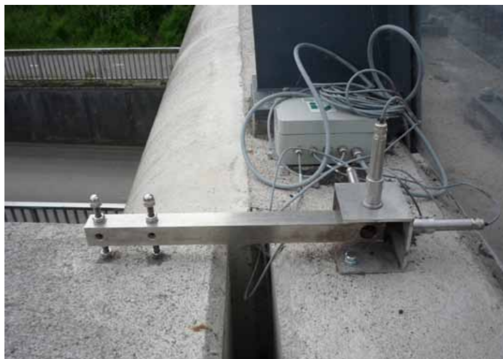
Afbeelding 47: 3D verplaatsingsopnemer tussen betonnen dek en landhoofd
