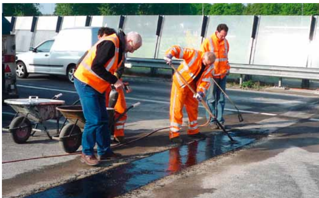
Afbeelding 58: Inbouw van de Prefab Silent Joint in de A50 bij Nistelrode
