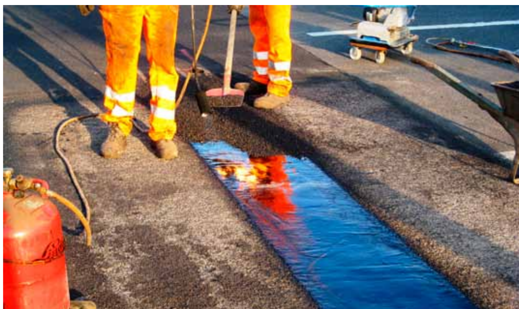
Afbeelding 49: Inbouw van de Prismo Joint
