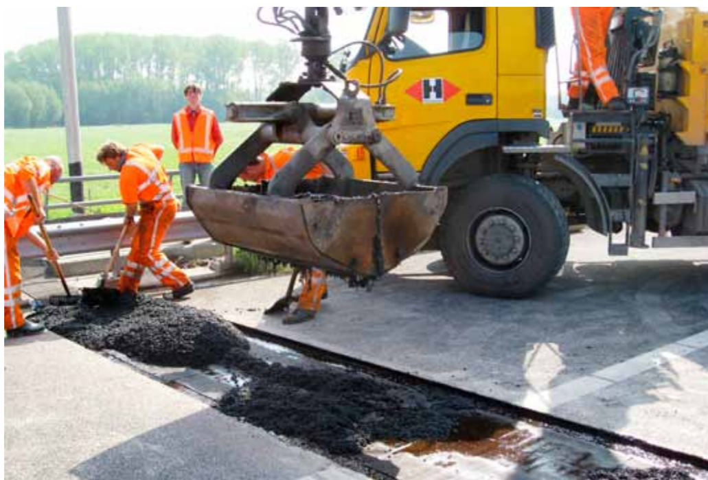
Afbeelding 54: Inbouw van de BrainJoint in de A50 bij Nistelrode
