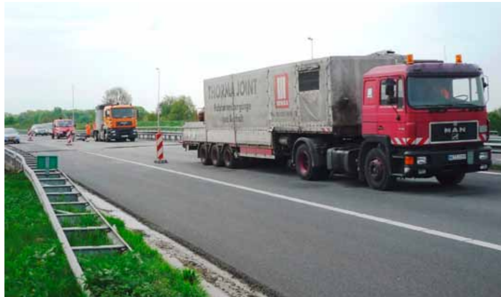
Afbeelding 55: Inbouw van de Prismo Joint in de A50 bij Nistelrode
