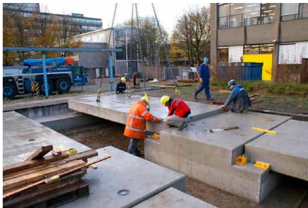
Afbeelding 19: Constructie van landhoofd en betonnen dekken op het LINTRACK terrein bij de TU Delft
