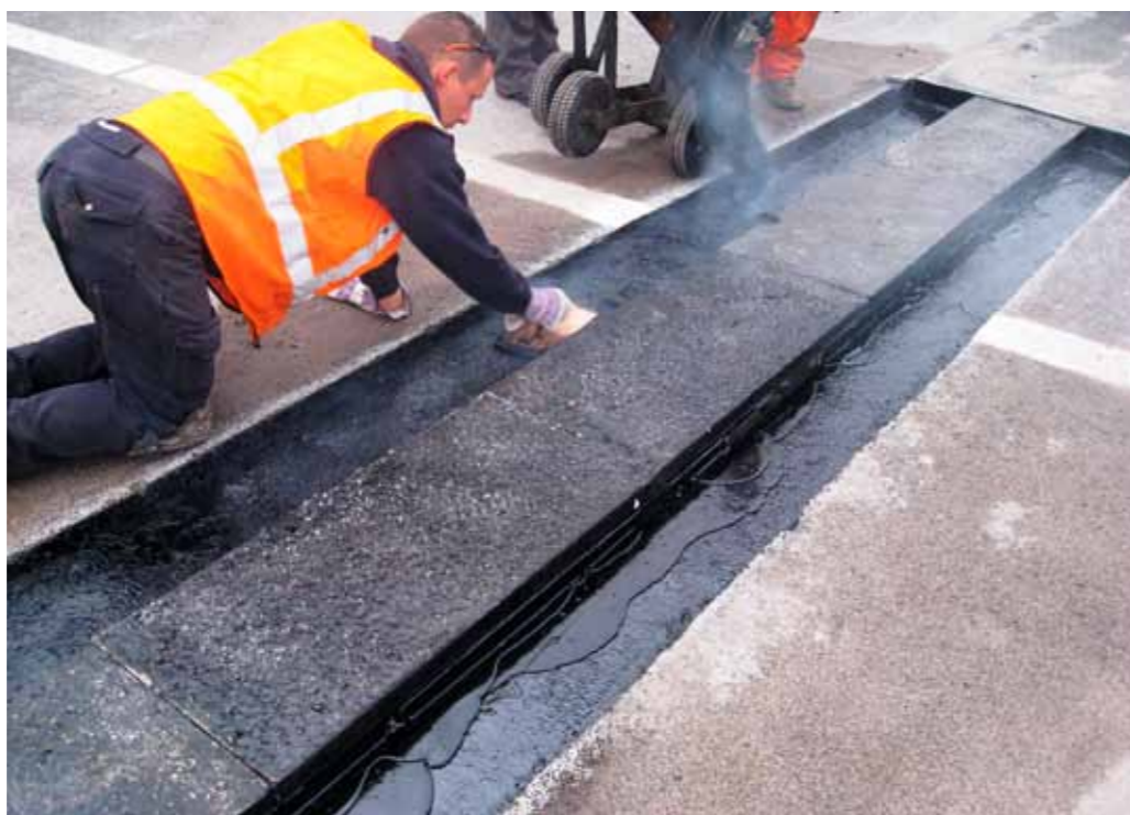
Afbeelding 53: Inbouw KLK Bituvoeg in de A50 bij Nistelrode
