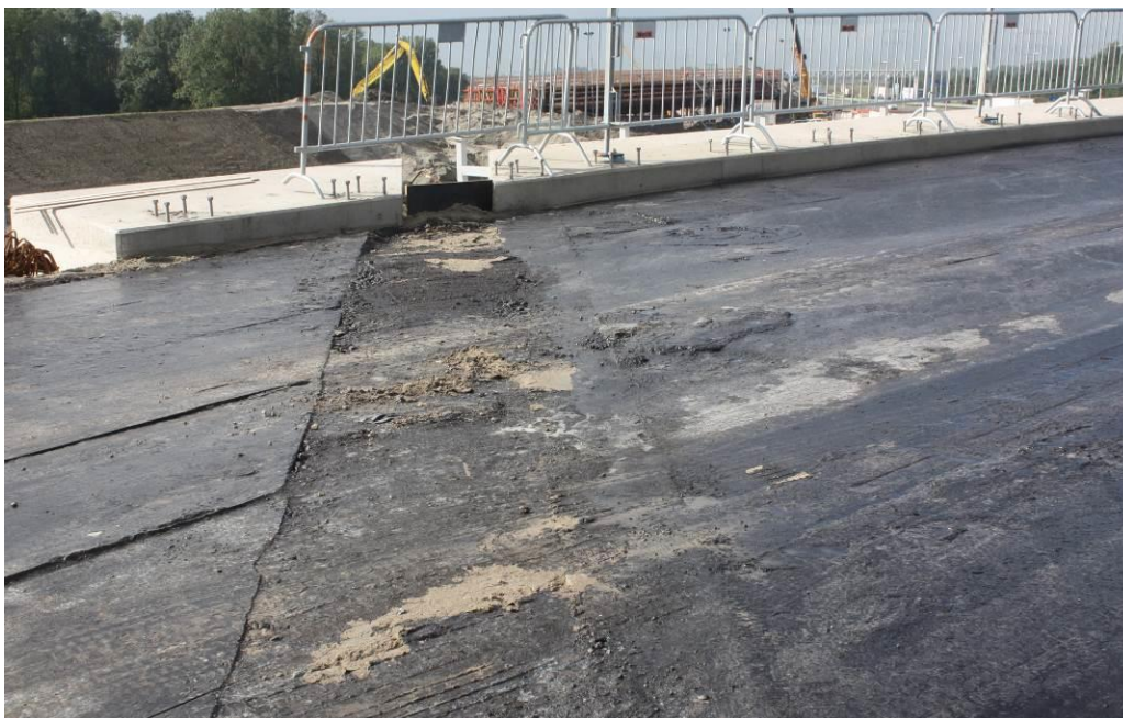
Figuur B6.3 Informatief: Vervuiling van kleeftlaag door materiaal uit voegsparing
