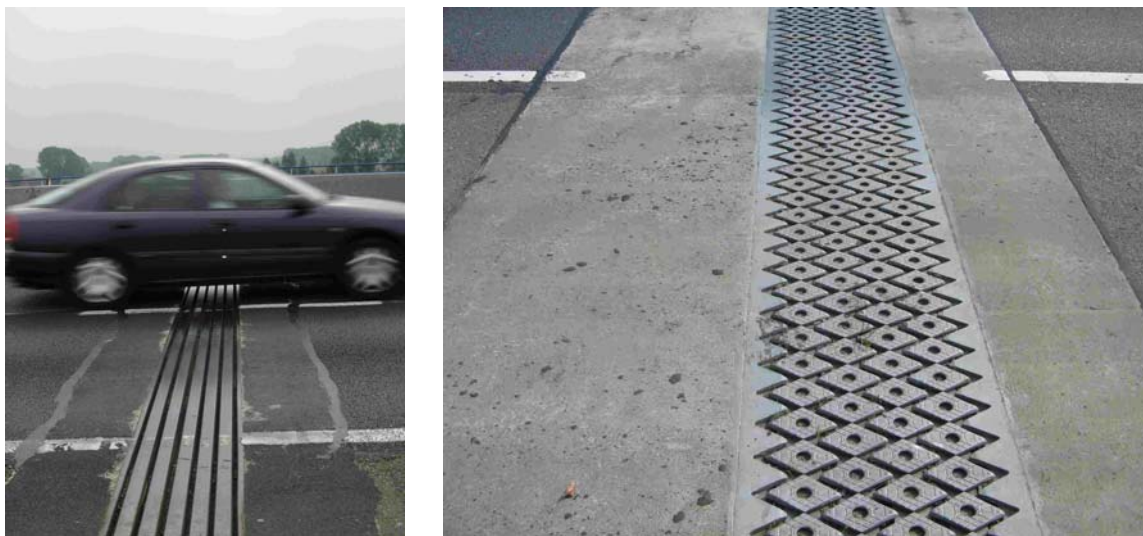
Figuur 2: Twee typen voegovergangen: links een Maurer balkroostervoeg, (lamellenvoeg) en rechts een Maurer XL (wiebertjesvoeg)
