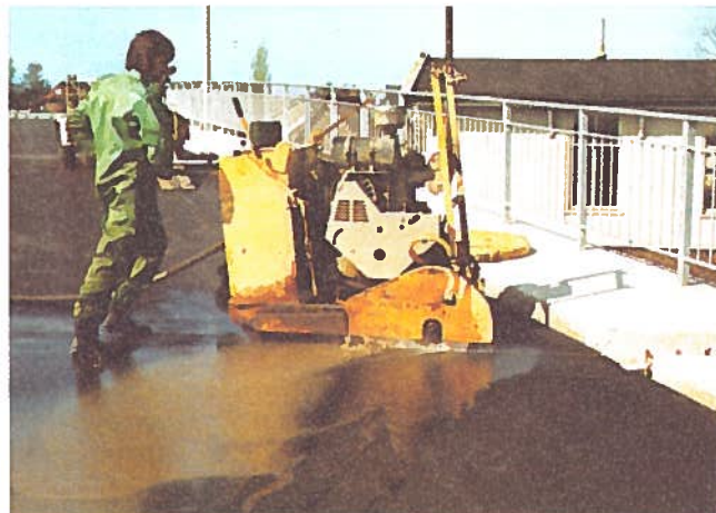
Maken zaagsneden in asfaltbeton.
