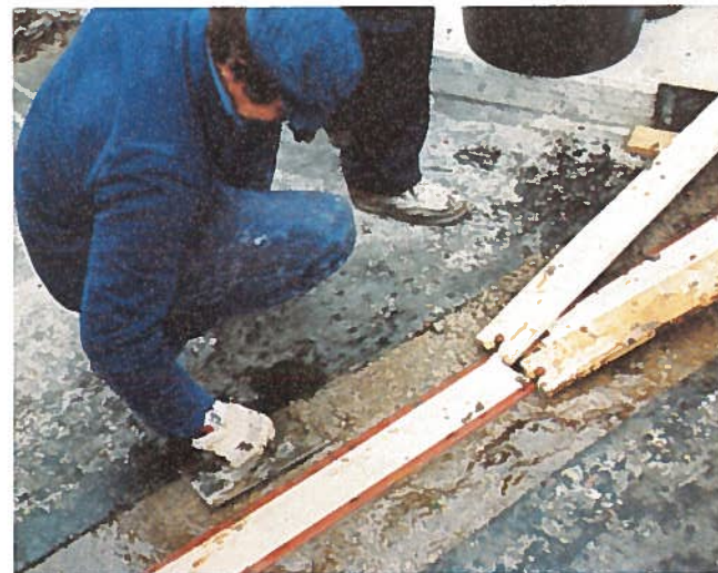
Het aanbrengen van de EP-mortel, welke zal worden voorzien van een anti-slip teerepoxy afwerking.
