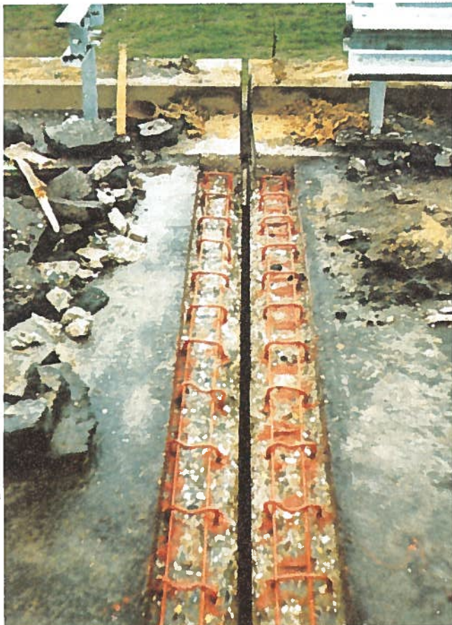
Voegopening na verwijdering asfaltbeton en aanbrengen EP-primerlaag gereed voor verdere afwerking, type AK.
