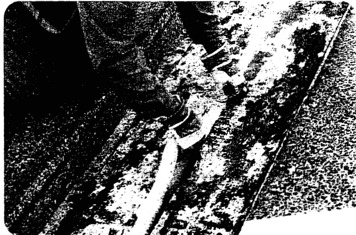
Foto 5 De rugvulling wordt aangebracht om het weglopen van de bitumen te voorkomen.
