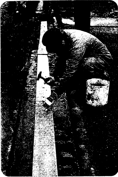
Foto 6 Het afdichten van de dilatatievoeg met een staalplaat. Op de plaat moet een laag gemodificeerde bitumen als primer worden aangebracht.
