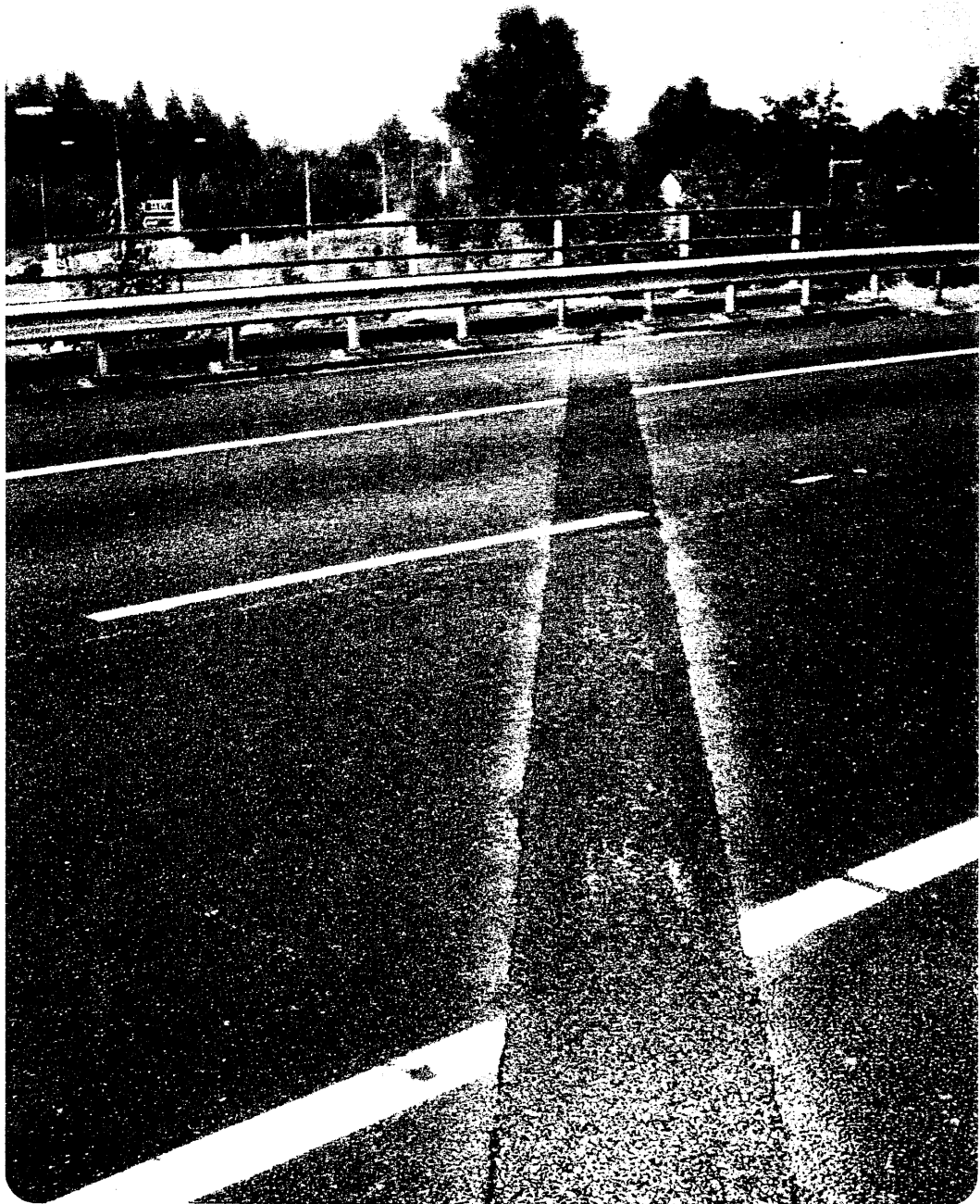
Foto 2 Schade aan een bitumineuze voegovergang: zichtbaar is het loslaten van de voeg en het afrekenen van de afdichtingsplaat.
