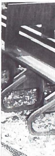
Auf die Randprofile aufgeschweißte Spannbleche sichern in einfacher Weise die werksseitige Einstellung der Dehnfugen.
