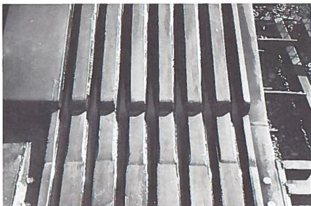
Schrammbord mit höherer Aufkantung. Tiefere Spalte am Schrammbord reinigen sich zur Fahrbahnseite.
