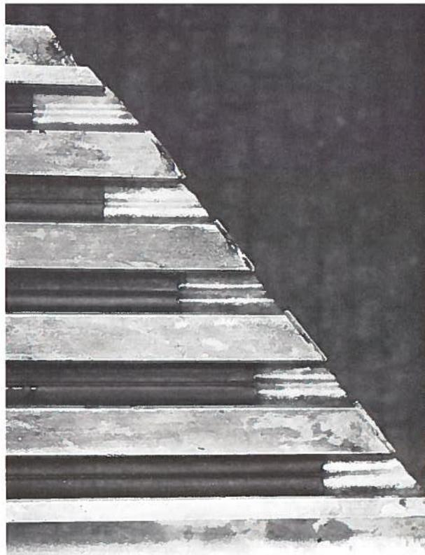
Mit Endprofilen aus Zellpolyurethan werden die Dehnprofile stirnseitig verschlossen. Das Gesimsblech kann entfallen.
