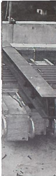
Verlegetraversen für große Dehnfugen mit eingebauten Justierschrauben
