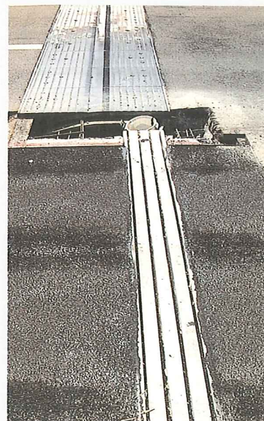
Austausch einer Rollverschuß-Konstruktion gegen eine Schwenktraversen-Dehnfuge
