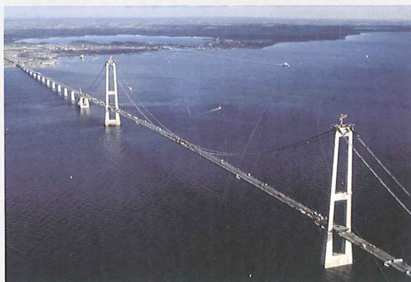
Storebælt Ostbrücke, Dänemark Baujahr: 1996 Hängebrücke Hauptspannweite: 1624 m Dehnfugentyp: 2 x DS2000 51,40 lfm 1 x DS1520 25,70 lfm 1 x DS960 25,70 lfm 1 x DS800 25,70 lfm
