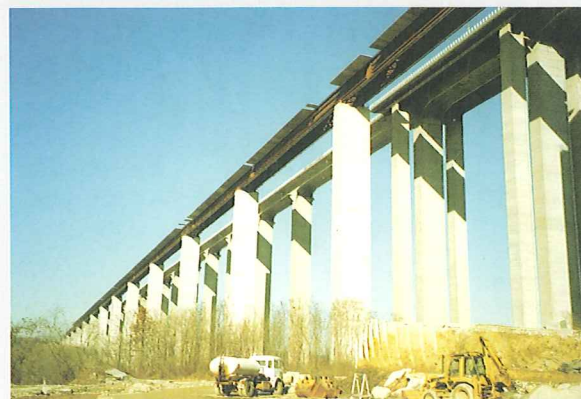
Stura di Demonte, Italien Baujahr: 1999 Stahlverbundbrücke Brückenlänge: 2750 m Dehnfugentyp: DS1200 24,50 m
