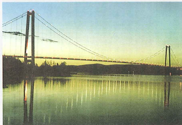
Höga Kusten Brücke, Schweden Baujahr: 1997 Hängebrücke Hauptspannweite: 1210 m Dehnfugentyp: DS1840 36,80 m
