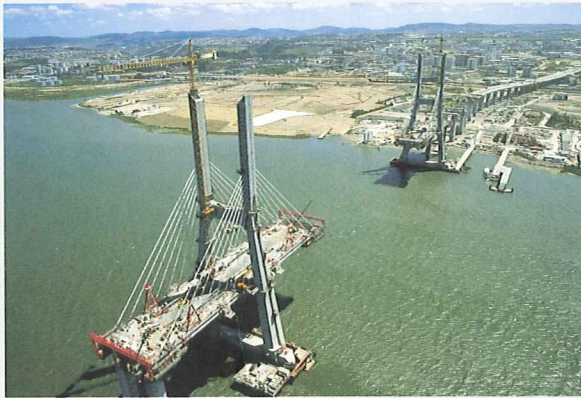
Vasco da Gama Brücke, Portugal mit fuse box für Erdbebenbewegung Baujahr: 1997 Schrägseilbrücke Hauptspannweite: 829 m Dehnfugentyp: DS1440 59,00 lfm
