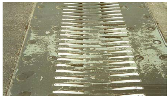
Abb. 4: Angebliche Fahrradsicherung an Fingerfugen
