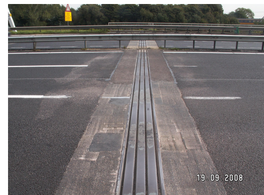
Situatie met betonnen overgangsbalken
