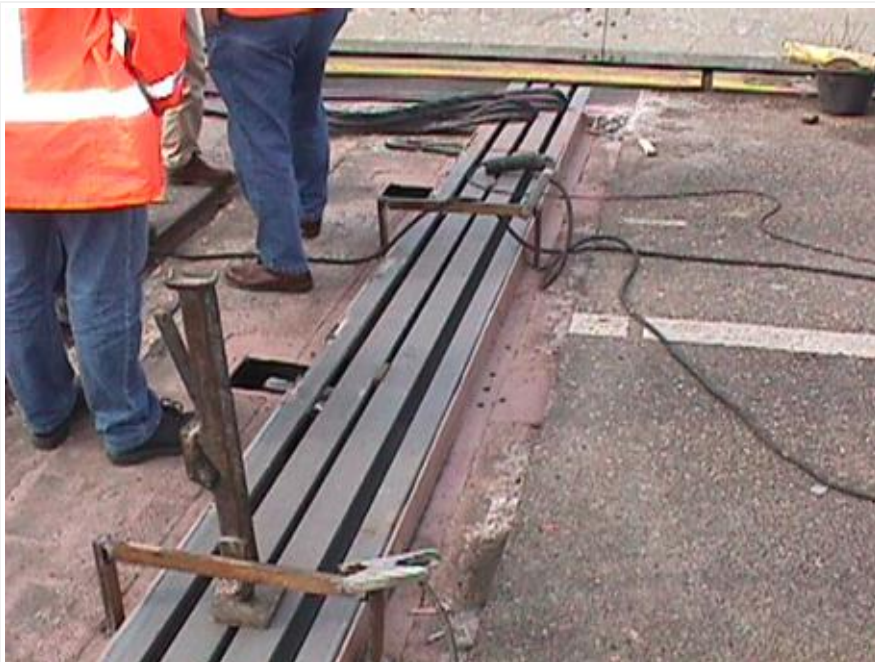
Montage nieuwe onderdelen
