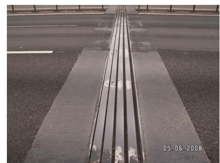
Stuurveren functioneren niet meer: ongelijke verdeling van voegspelen
