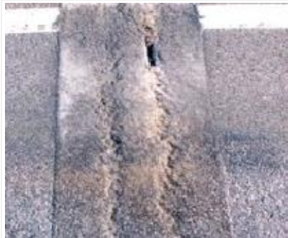
Scheuren ter plaatse van uiteinden afdekplaat
