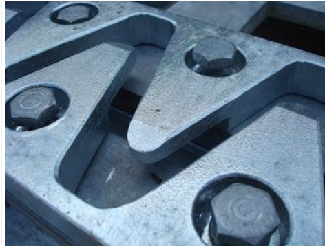
Montage van sinusplaten
