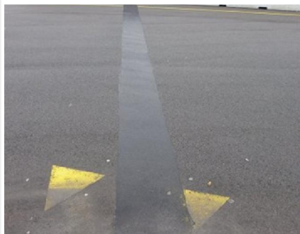
Door het Indrukken van afstrooimateriaal in de voegbalk ontstaat onvoldoende stroefheid.
