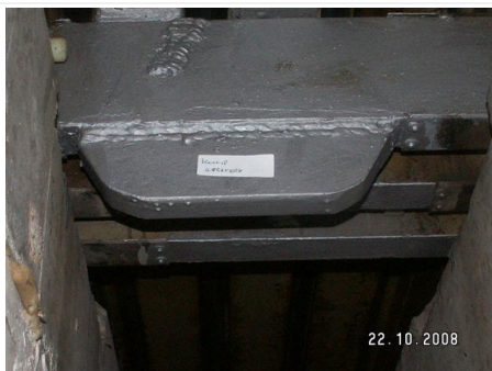
Herstelde scheur vanuit verbindingslas in traversebalk. Traversebalk verzwaard.
