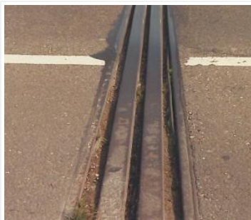
Voegprofiel uit klauwconstructie
