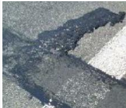
Het uitrijden van materiaal. Niet geschikt voor bochten hellingen en zwaar verkeer.
