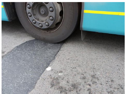
Het uitrijden van materiaal. Niet geschikt voor bochten hellingen en zwaar verkeer.
