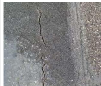
Scheuren boven de staalplaat
