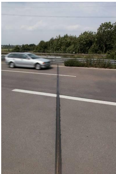
Voorbeeld D60 zonder rijrooster Volgens Duitse regelgeving: Ub1 constructie.
