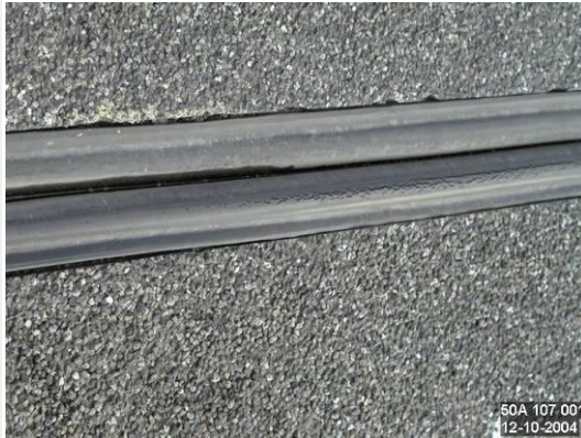
Schade door aanrijding
