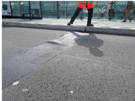
Door het Indrukken van afstrooimateriaal in de voegbalk ontstaat onvoldoende stroefheid.
