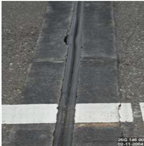
Rafeling: slechte uitvoeringskwaliteit / te weinig druk op profiel
