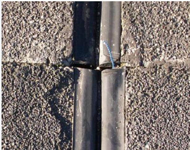
Openstaande stortnaad / niet ge vulkaniseerde voegprofiel delen
