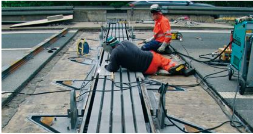
Montage van de nieuwe voegovergang Kast in Kast.
