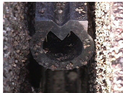
EKV: Enkele Kleine Voeg. Dilatatie tot 15 mm
