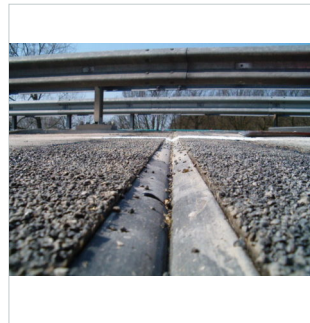
VA30 rubberprofiel tussen 2 randbalken
