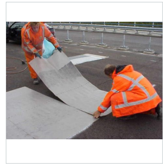
Plaatsen rekspreidende inlage
