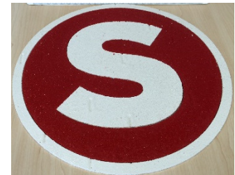
Figuur 4 Markering Silent Joint op voegconstructie
