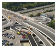
Bridge Glattzentrum (CH)
