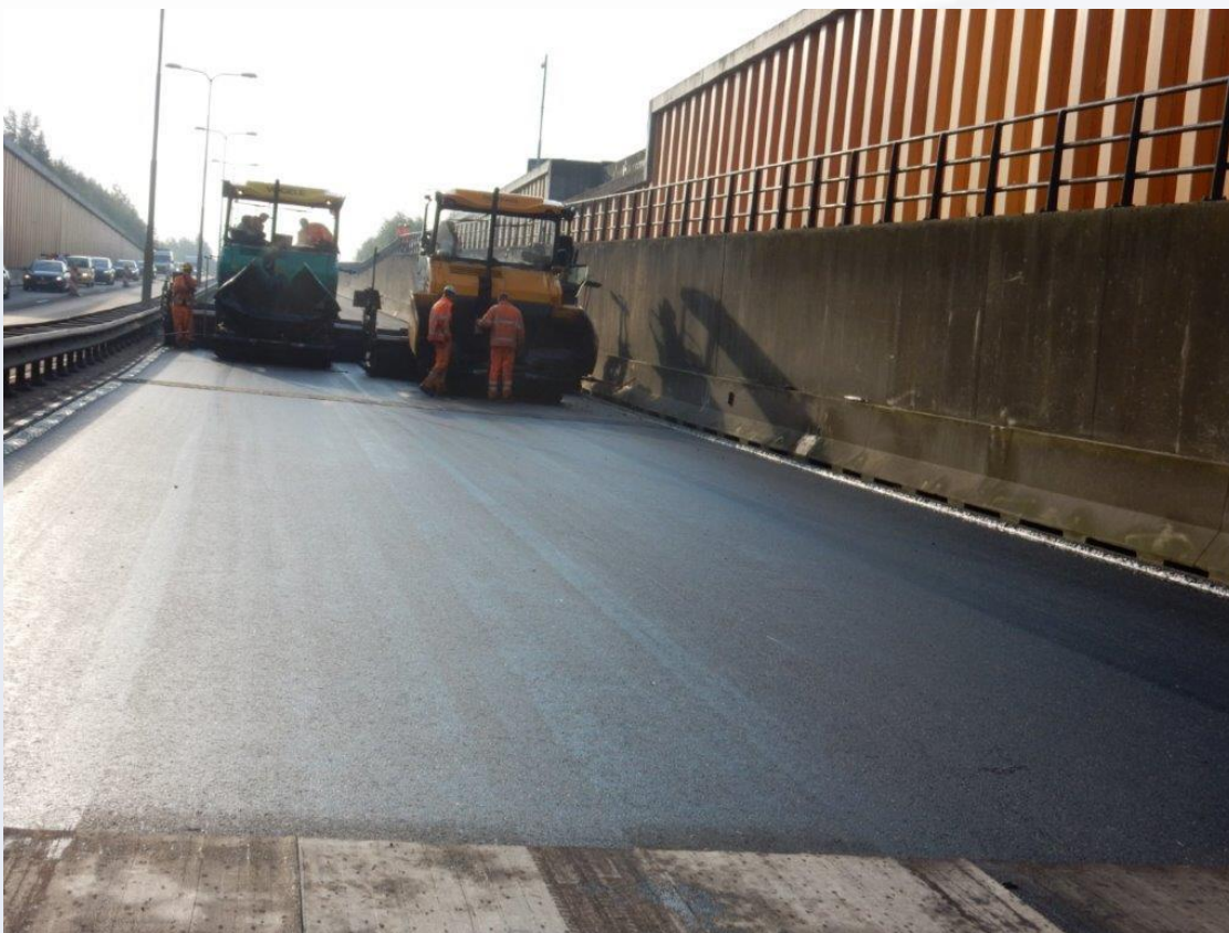
Voorbeeld aanleg BrainJoint (hier in een tunnelbak)
