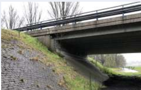
Constructietype (risico op instabiliteit door aantasting wapening)
