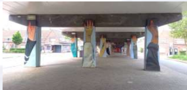
Constructietype (risico op instabiliteit door aantasting wapening)
