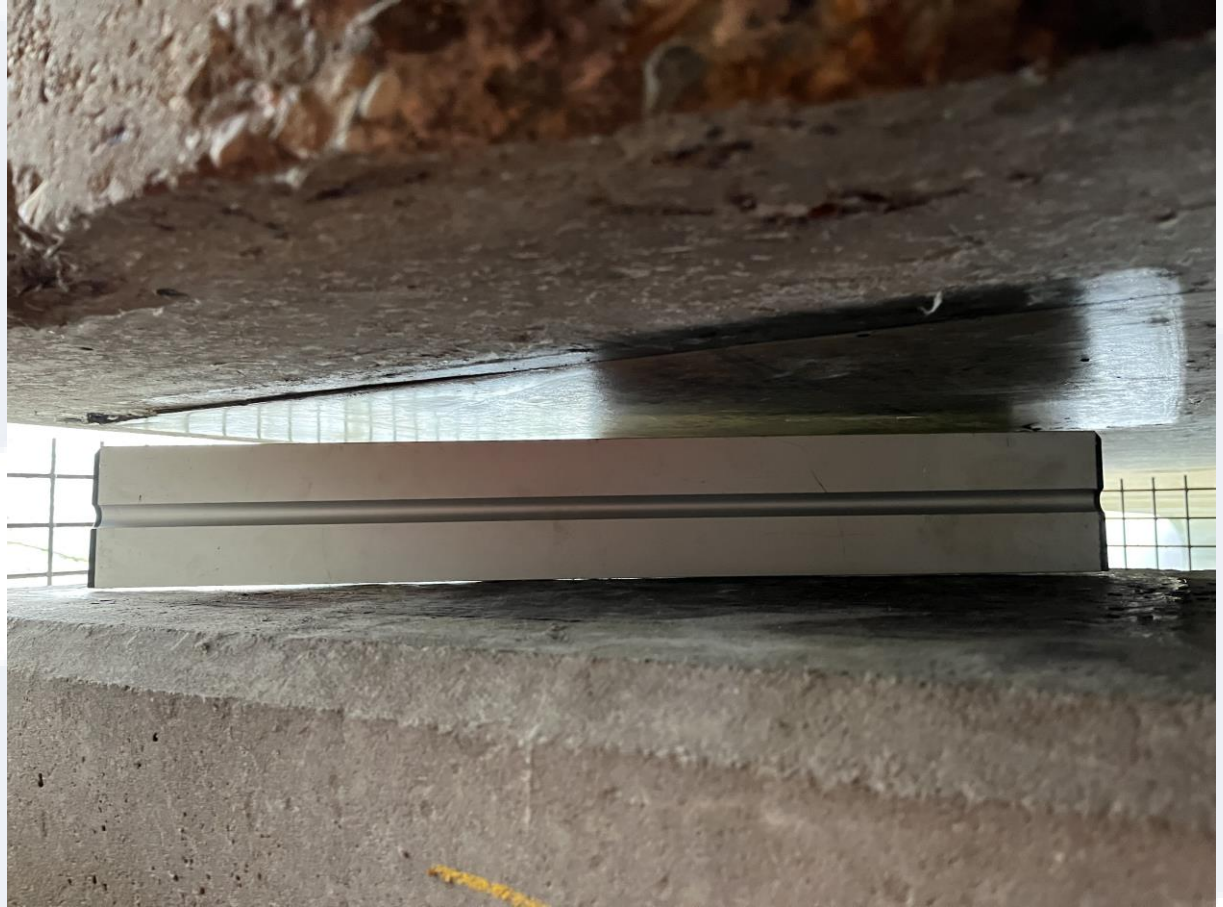
Onvlakheid contactvlak onderbouw
