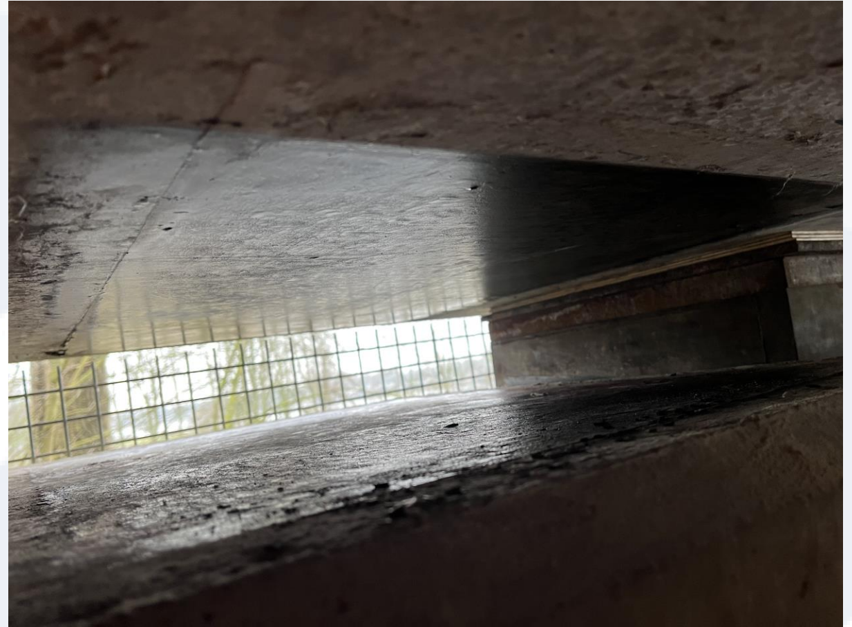
Vettig contactvlak onderbouw, wel ruw afgewerkt
