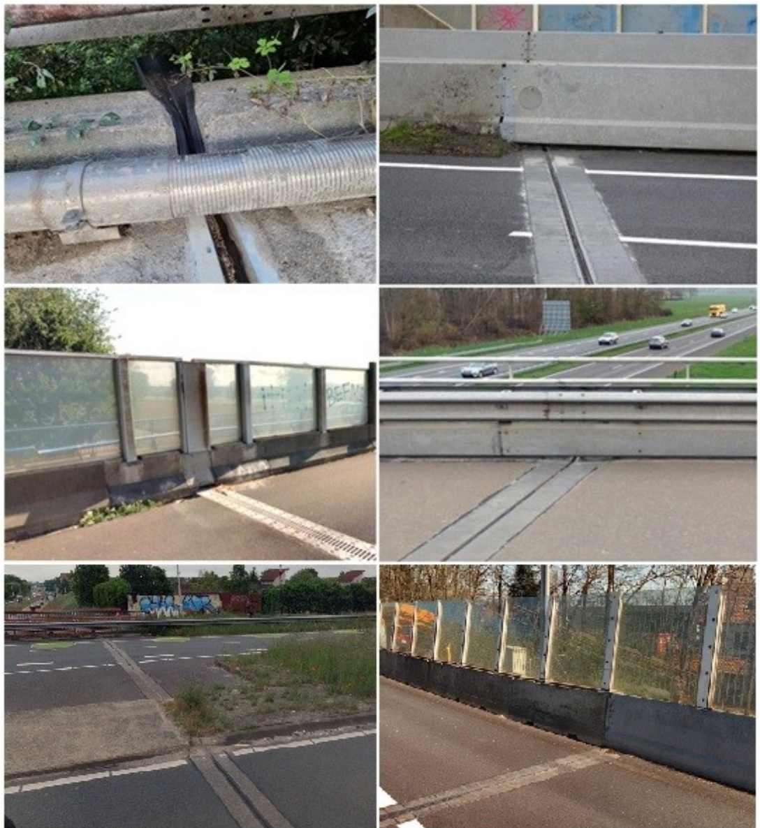
Figuur 4-3 Raakvlakken t.p.v. bermen en schampkanten
