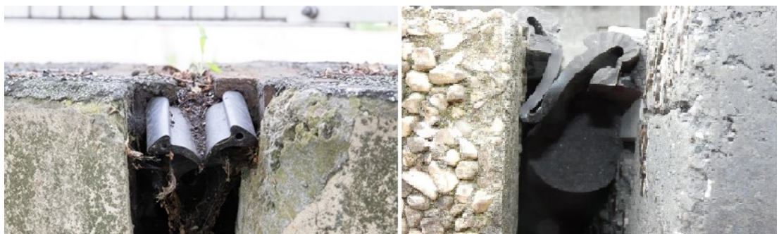
Figuur 4-1 Identificatie voegovergangssysteem
